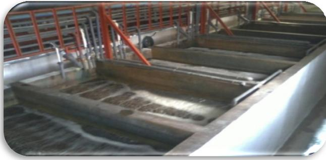
*Figure 1 : cuves d'oxydation*
