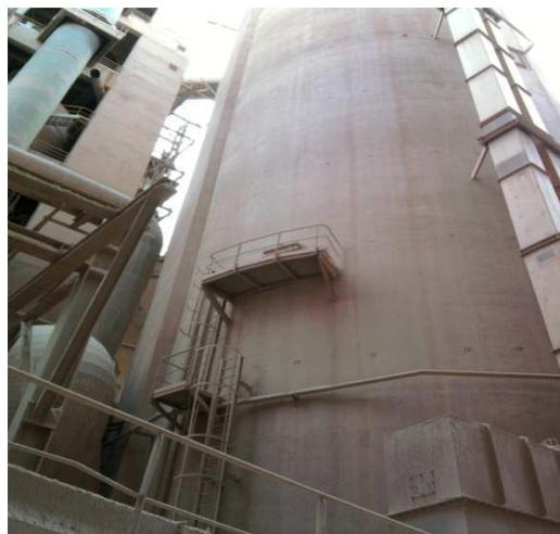
Figure 10 : Silo d'homogénéisation
