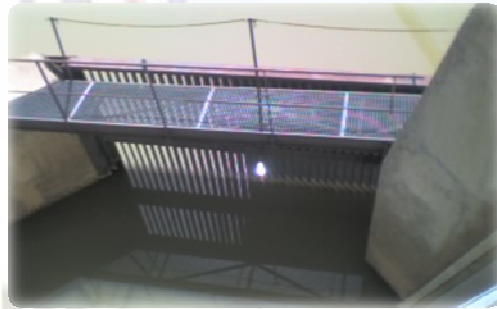
Photo N°2 : Prise d'eau contenant une grille
