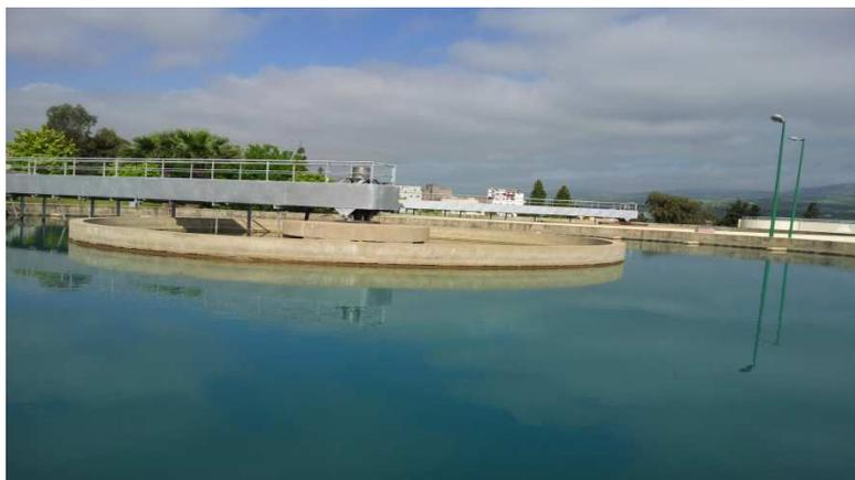
**Figure 5 : Décanteur**
