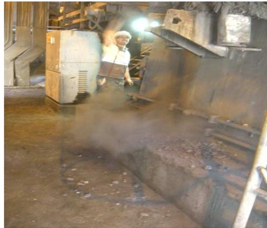
**Figure 45 : Débouchage de la gaine d'air de nettoyage**
