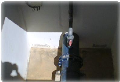
figure5 : Canne injection du chlore
