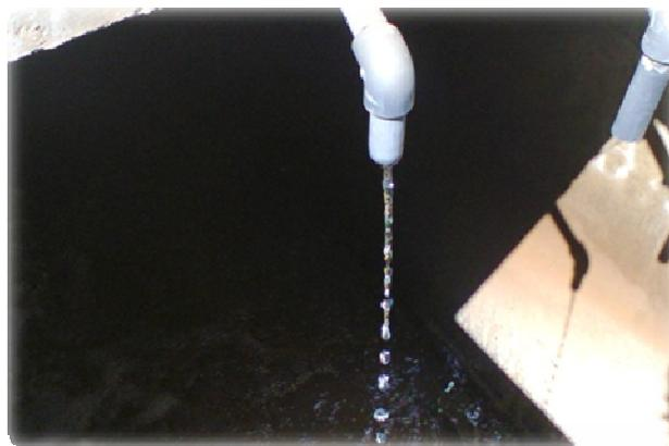
*figure7 : Bâche d'ajout de coagulant.*
