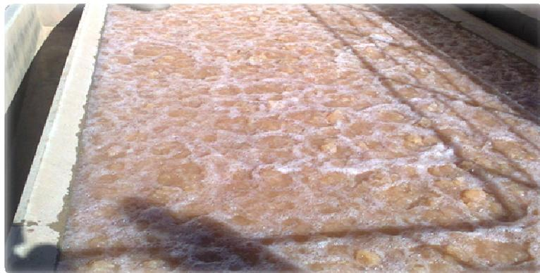
figure11 : Lavage d'un filtre
