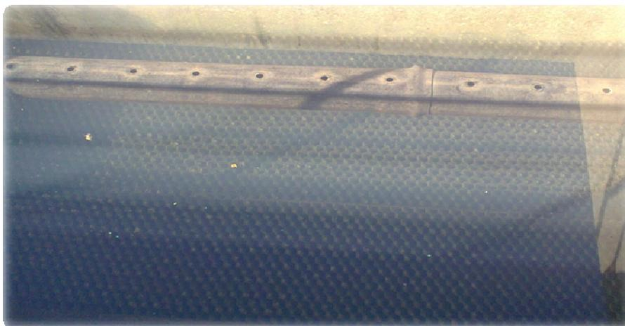
Figure8 : Décanteur lamellaire
