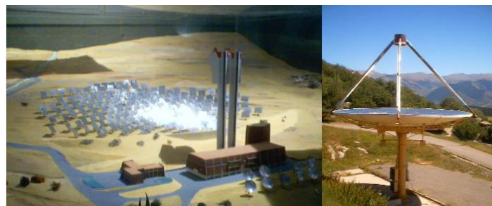
Figure I.14 : champ d'héliostat -centrale solaire Thémis France.
