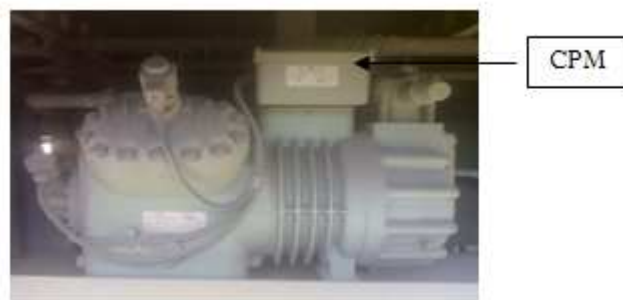
FIGURE 9: LE MOTO-COMPRESSEUR
