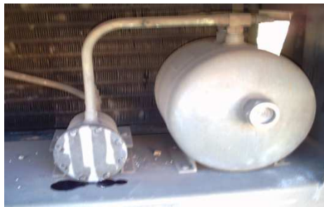
FIGURE 8: BOUTEILLE ACCUMULATRICE ET FILTRE DESHYDRATEUR.
