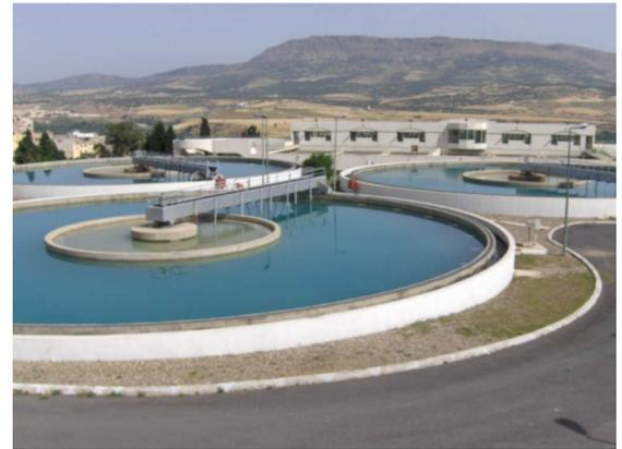
Figure 7 : Décanteur
