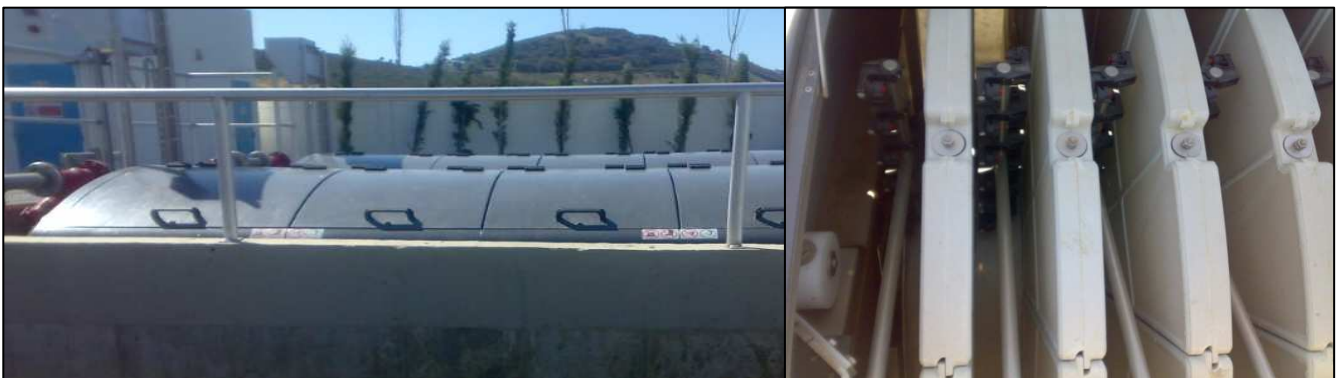
Photo 7 : Filtre à tamis rotatif (10µm)
