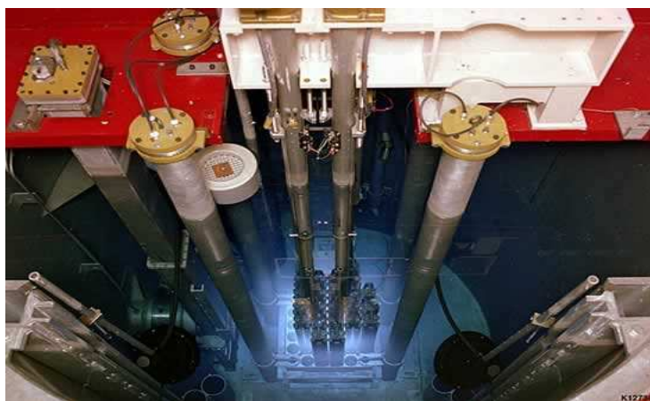
Figure II-2 : Cœur du réacteur nucléaire
