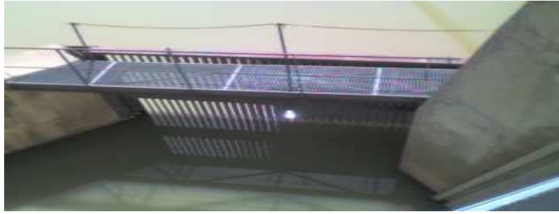
Photo 2 : prise d'eau contenant une grille.
