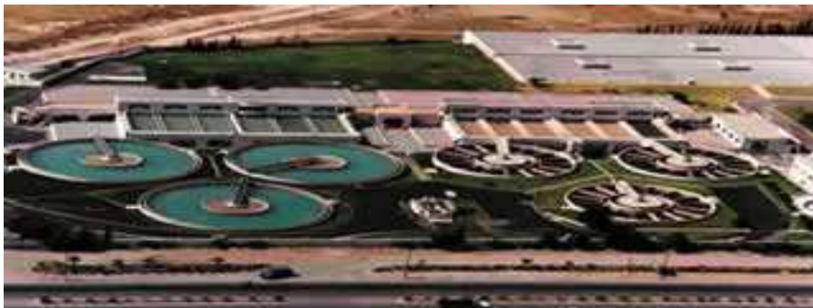
Photo 1 : Station de traitement d'Oued Sebou
