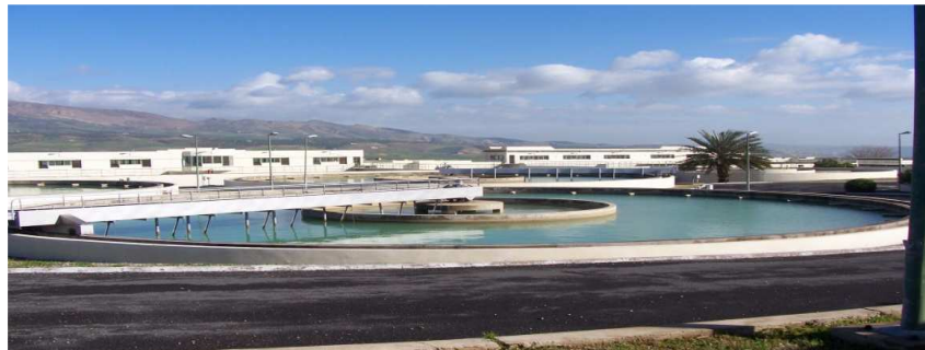
Photo 6 : Décanteur
