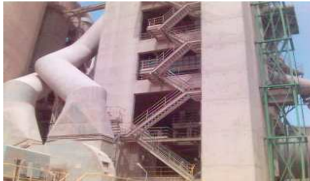
Figure 7 : Tour EVS de préchauffage
