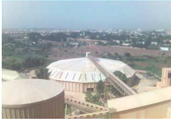
Figure 3 : Hall d'homogénéisation d'une capacité de 18000 t
