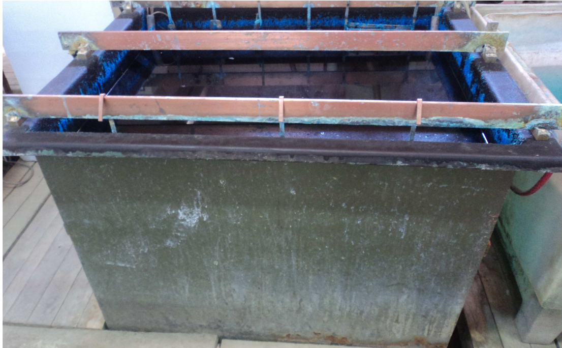
Figure7 : photographie d'un bain de cuivrage acide
