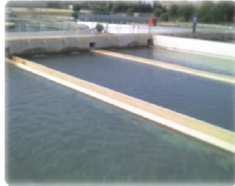
Figure 7 : Filtres à sable
