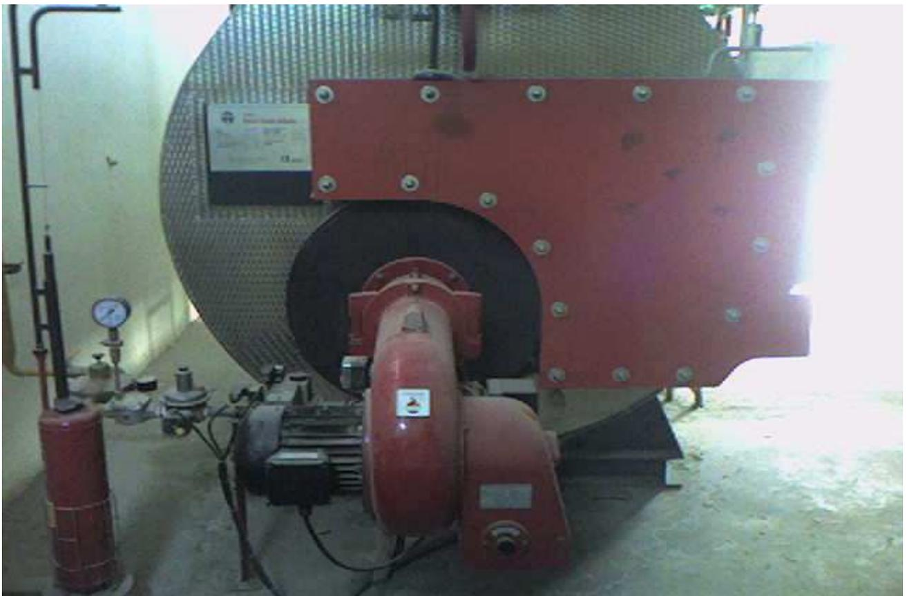
A l'intérieur de la chaudière, il ya un grand foyer dans lequel un brûleur refoule le propane, lors du refoulement un arc électrique se crée entre deux électrodes avec une haute tension, à ce moment là une grande flamme s'allume en créant une grande température à l'intérieure de la chaudière, ce qui fait vaporiser l'eau, cette vapeur sera transférée par des conduites vers la ligne de production pour couvrir les besoins de vapeur de la société.
