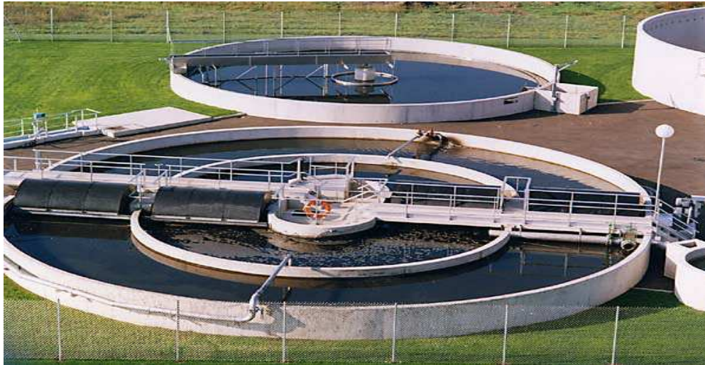
Photo 1 : Bassin de décantation
