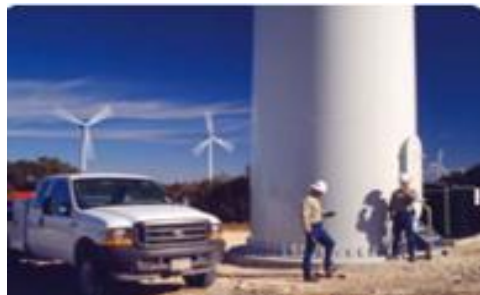
Figure I.4. La tour d'une turbine
