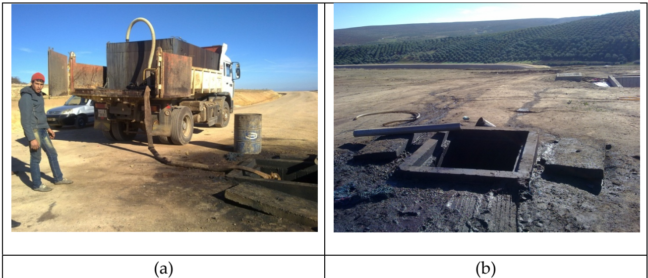
Figure 10 : (a) Camion citerne versant les margines dans le regard type (ABHS). (b) regard type (photo prise sur terrain le 8/5/2015).
