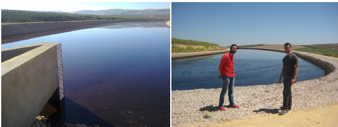
Figure 20 : Bassin d'évaporation (photos prises sur terrain le 8/5/2015).
