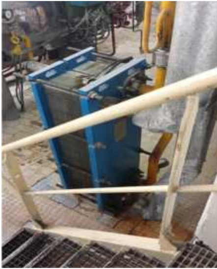
Figure7 : Echangeur à plaque
