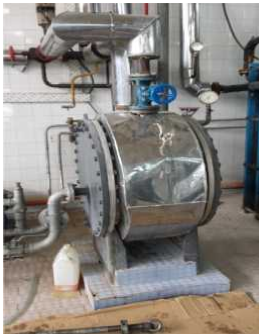
Figure 9 : Echangeur tubulaire
