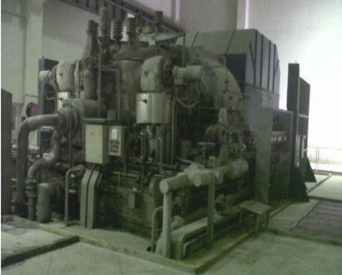
Figure 11: Groupe turbo alternateur de centrale thermique
