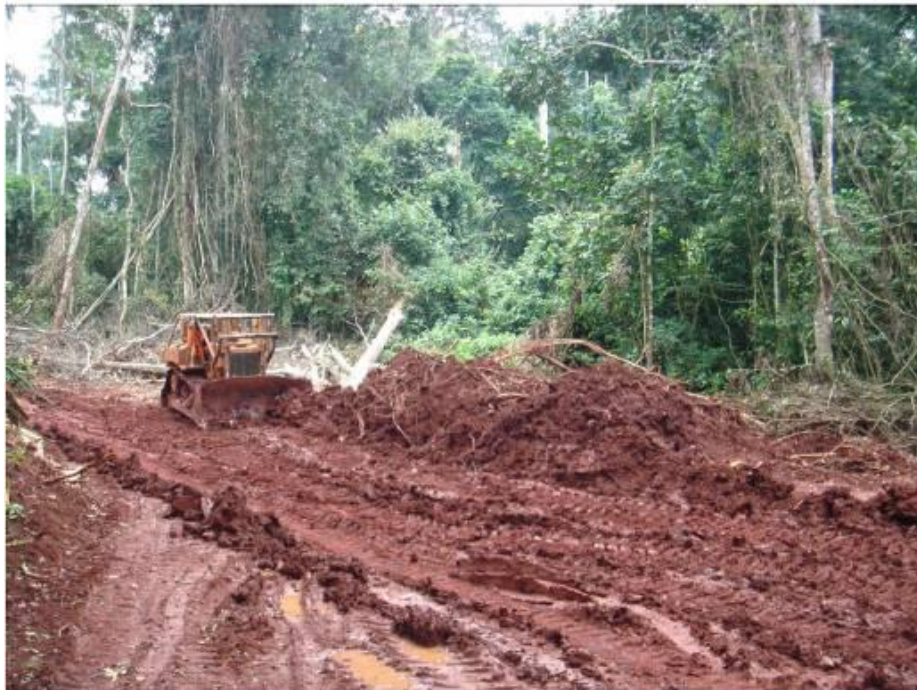
Figure 21 : Nivellement d'une piste forestière
