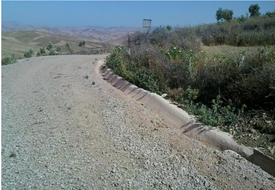
Figure 17 : Fossé de piste de Tghat
