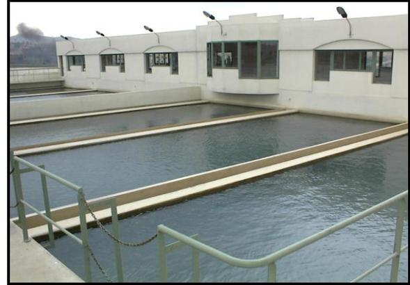
Figure 8 : opération de filtration sur sable dans la station de traitement
