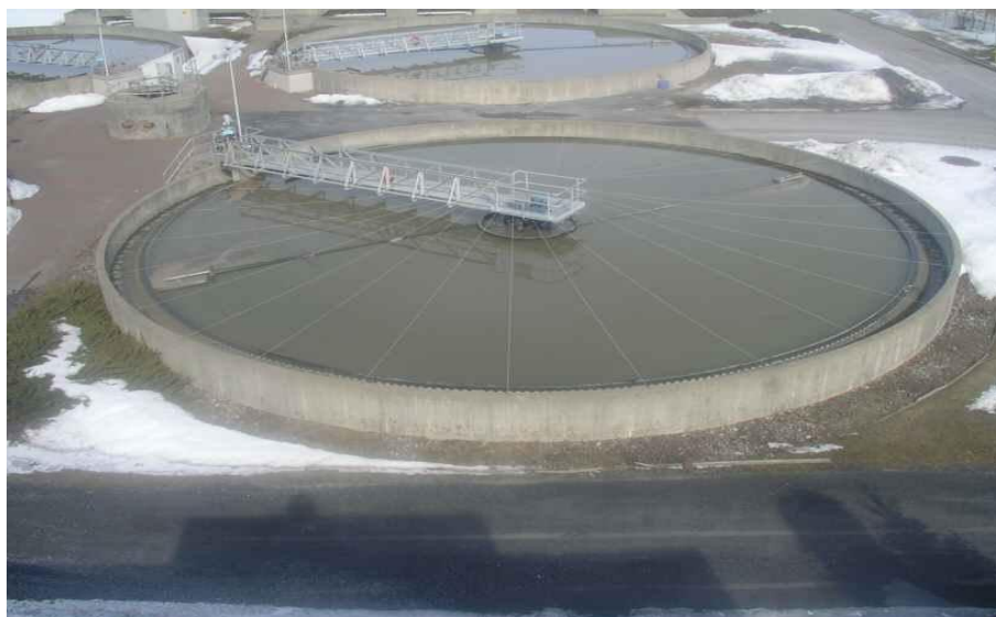
Figure 5 : Schéma d'un décanteur
