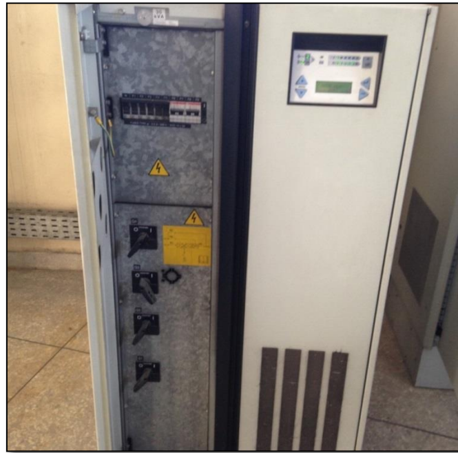
Figure 8: Alimentation Sans Interruption ASI de l'ONCF
