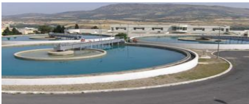
Figure 1 : Opération de décantation à la station de traitement de Aïn Nokbi
