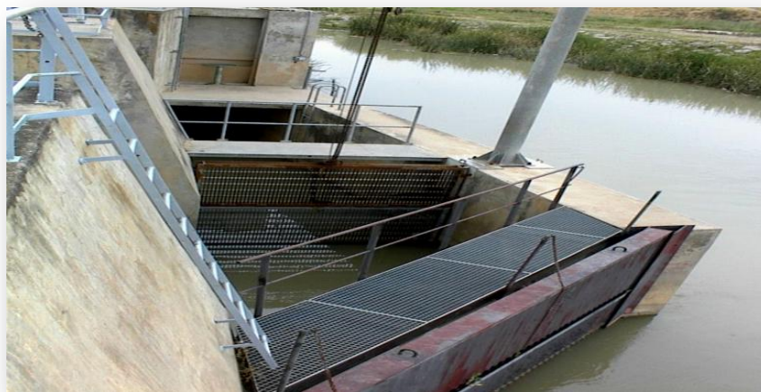
Figure 2: Opération de dégrillage à la station de prétraitement.
