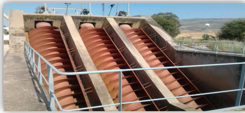
Figure 2 : Opération de relevage
