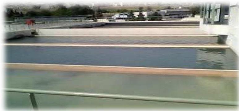
Figure 8: Filtres à sable
