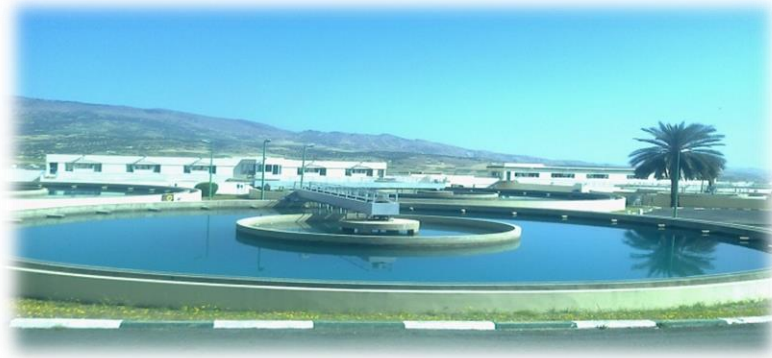
Figure 7: Décanteur a racleur
