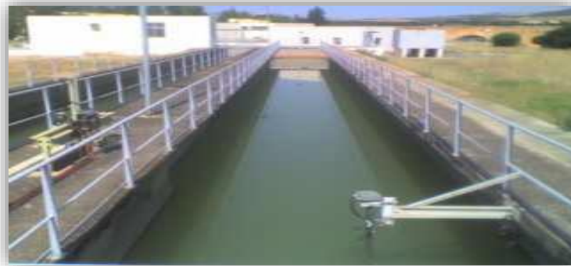
Figure 3 : Opération de dessablage
