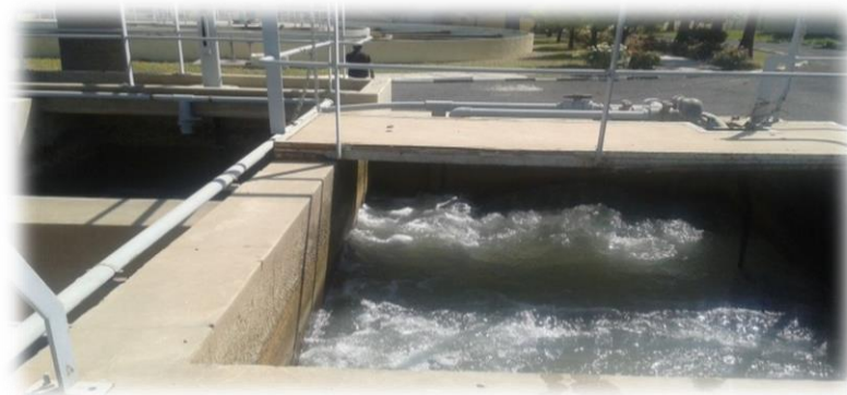
Figure 6: Répartiteur-mélangeur
