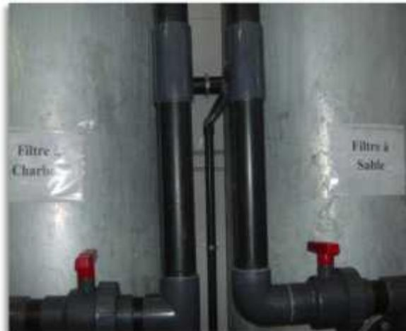
Figure N°3 : Filtre à sable & filtre à charbon.
