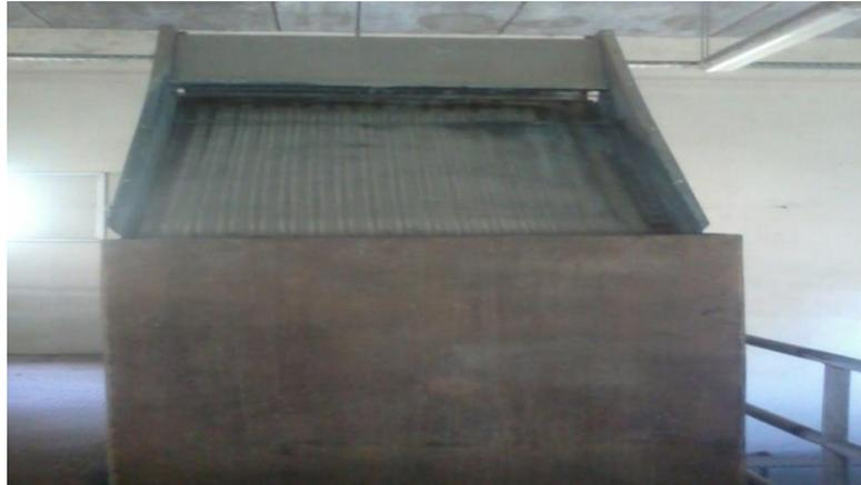
*Figure 11 : photo d'un dégrilleur*
