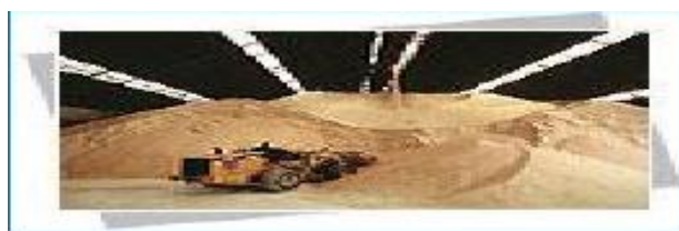
Figure 8 : silo de stockage du sucre brut
