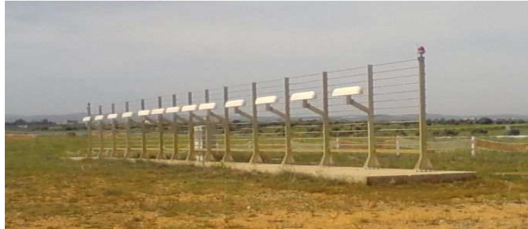
Figure 2 : Les antennes de localizer
