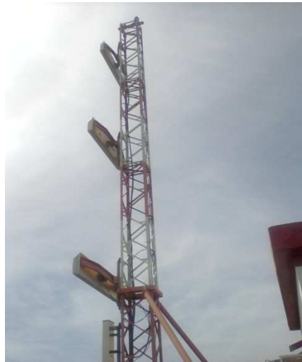
Figure 3 : L'antenne du glide path
