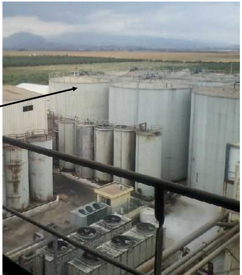
Fig.24 : Les citernes de stockage de l'huile brute de capacité de 2000 Tonnes
