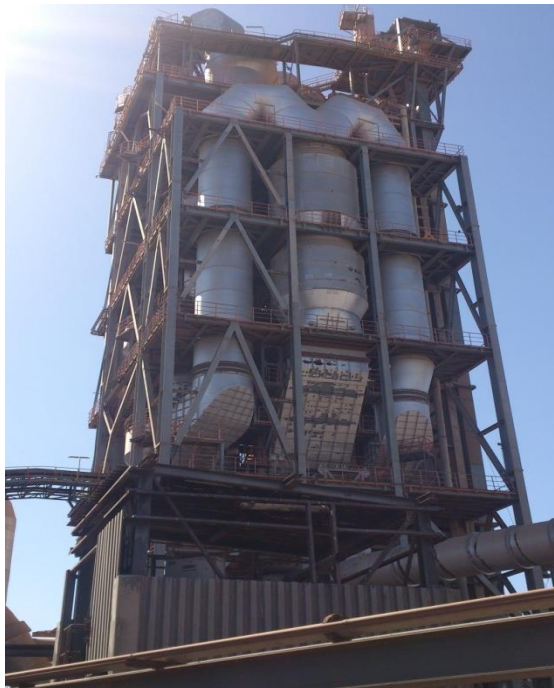
Figure 8: Tour de préchauffage.
