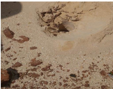
Figure 19: Trou réalisé par foreuse.
