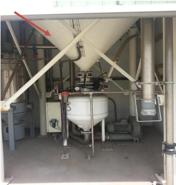
Figure 9: le silo de "36 tonnes" du DS 1
