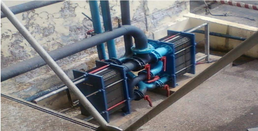
Figure 17 : Photo des échangeurs à plaques au sein de la raffinerie LCM
