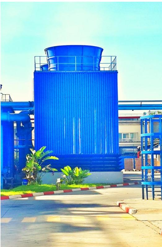
**TAR** ou **Tour Aéro-Réfrigérante** est un échangeur de chaleur "air/eau", dans lequel l'eau à refroidir est en contact direct avec l'air ambiant.
