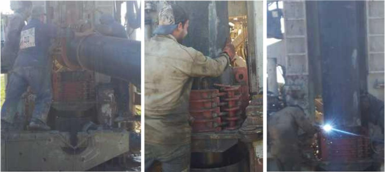
**Figure 26 : Le revêtement des ouvrages avec des tubes qui sont soudés l'un avec l'autre**
