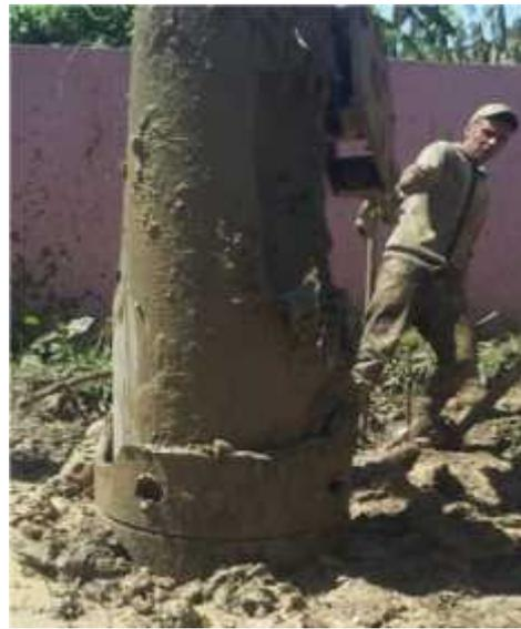
**Figure 19 : Foration par la méthode de battage carottage**
