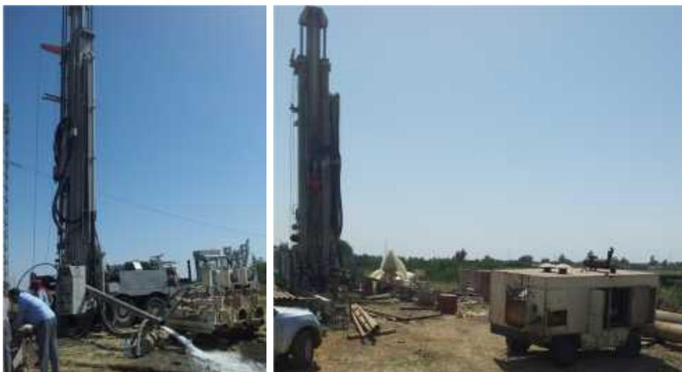
**Figure 45 : Développement pneumatique à l'air lift**
