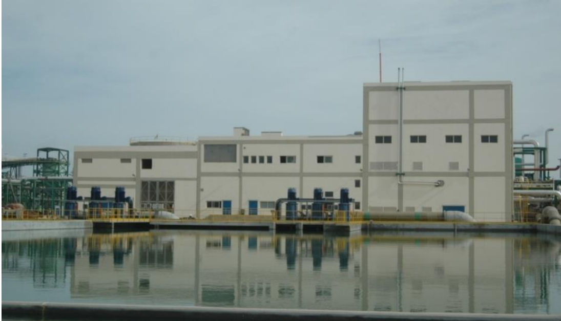
Figure 6: Vue de la centrale thermoélectrique
