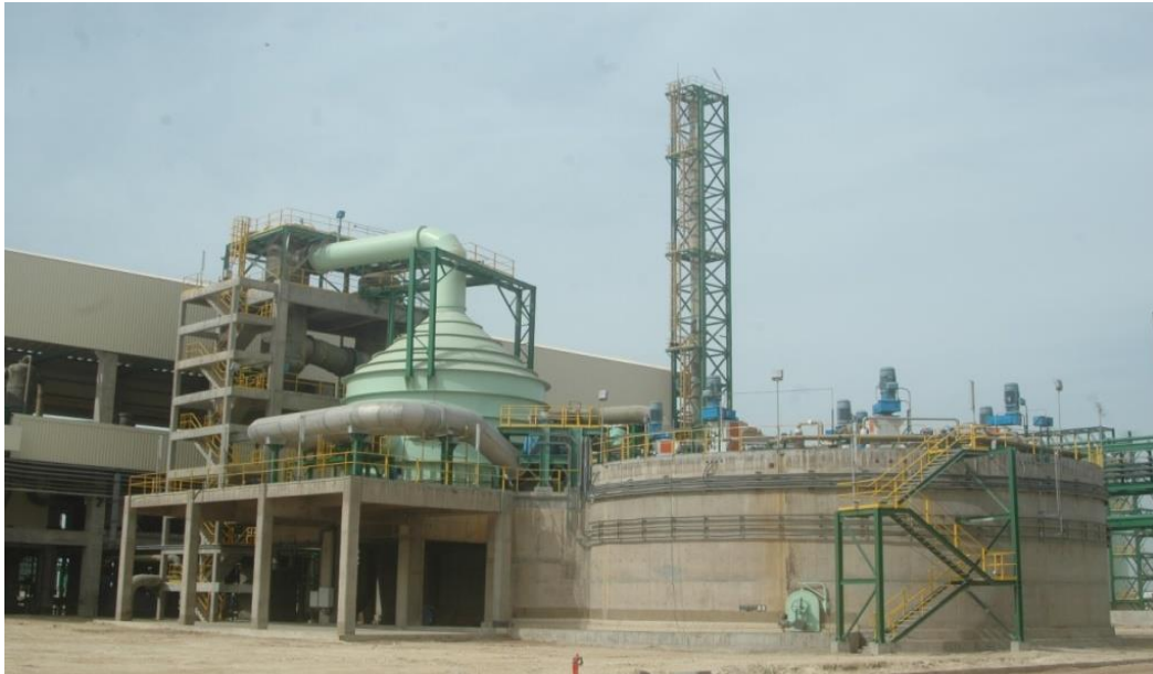
Figure 5: Vue de l'atelier phosphorique (attaque-filtration).
