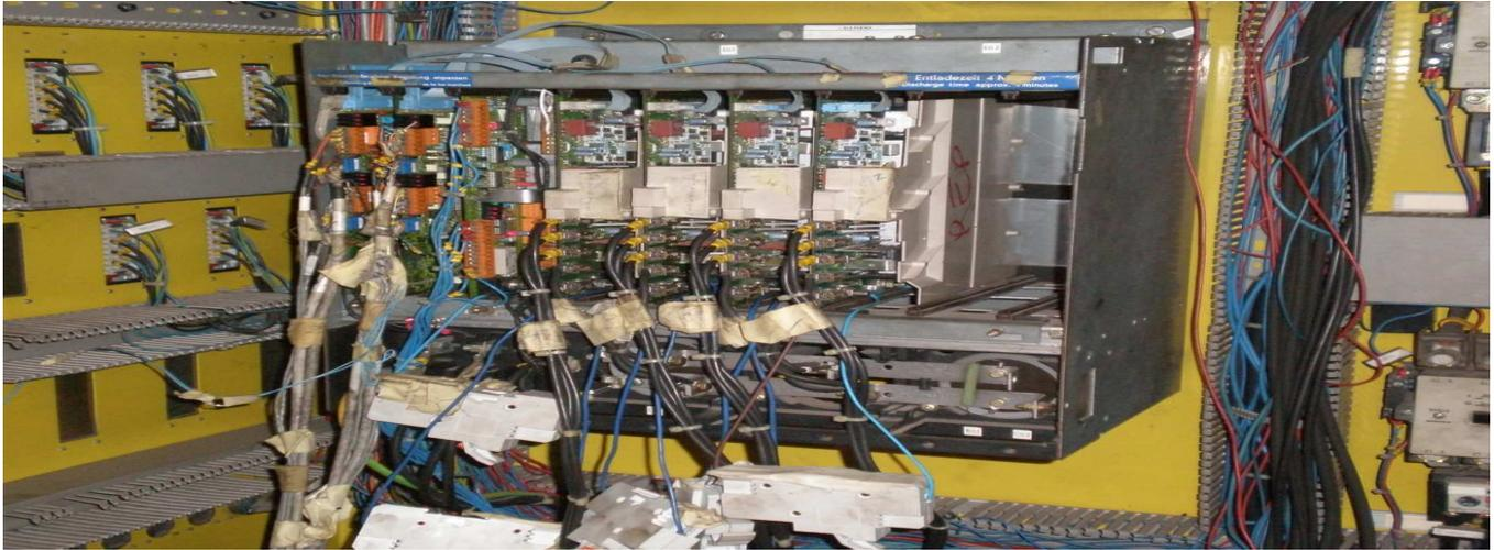
*Fig 11 : L'Onduleur à modulation de largeur d'impulsion à transistors pour entraînements d'avance triphasé 6SC61-4A-Z*
