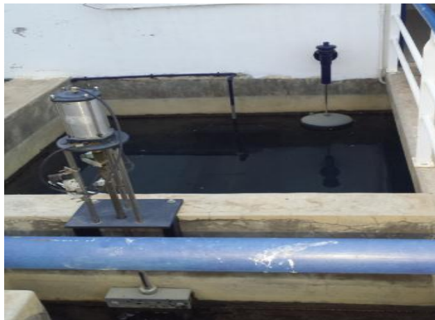
Figure 7: filtre à sable
