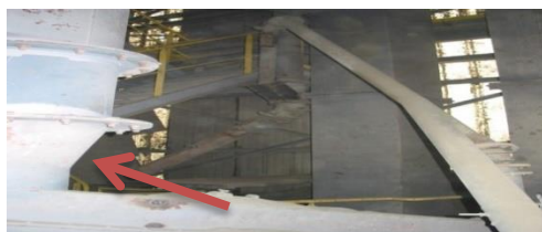
Figure 27 : dépoussiérage aérogliissière des rejets
