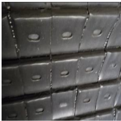
Figure 33-5 : Les blindages releveurs RAS
