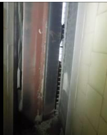
Figure 31-12 : Le registre rectangulaire d'air frais est ouvert à 30% (RAS)
