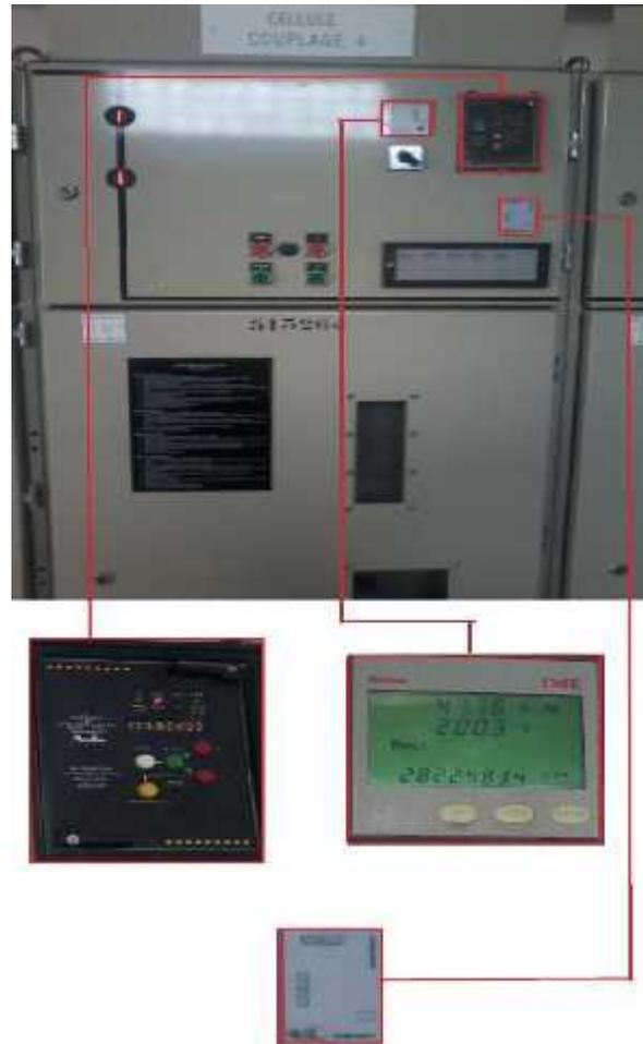
1. Pour l'armoire de commande il est composé de plusieurs relais et disjoncteur modulaire, en plus de relais de température. A l'interface de cette armoire ce trouve :
