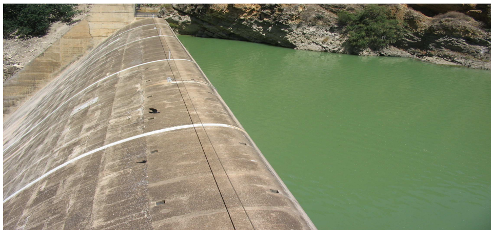
Photo n°6 : Barrage EL Kansera.
