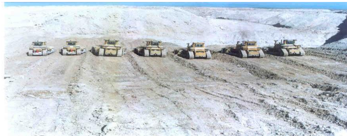
Figure5 : Décapage par Bulldozers
