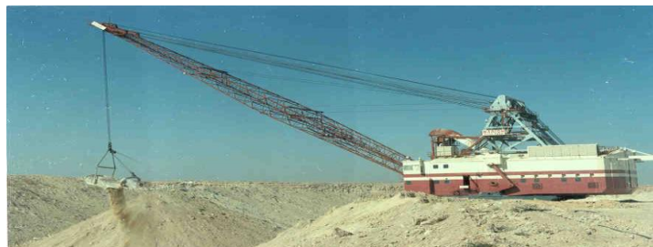
Figure6 : Décapage par Draglines
