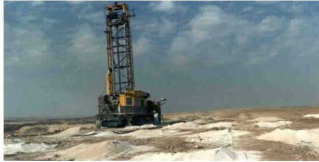
Figure3 : Foration par la sondeuse 45R
