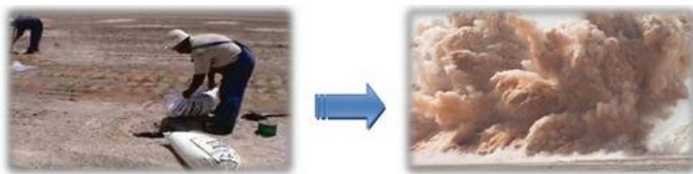
Figure4 : Opérations du sautage par des explosifs
