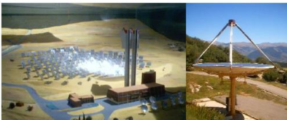
Figure II-4 : champ d'héliostat -centrale solaire Thémis France [29]
