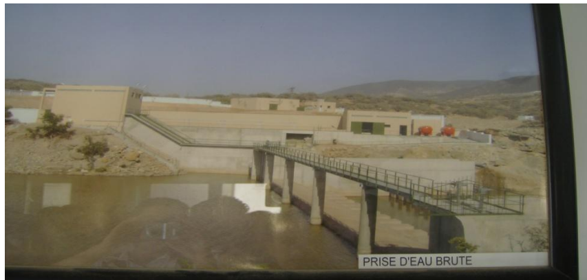
Figure 2 : Barrage My. Abdellah -prise d'eau brute.
