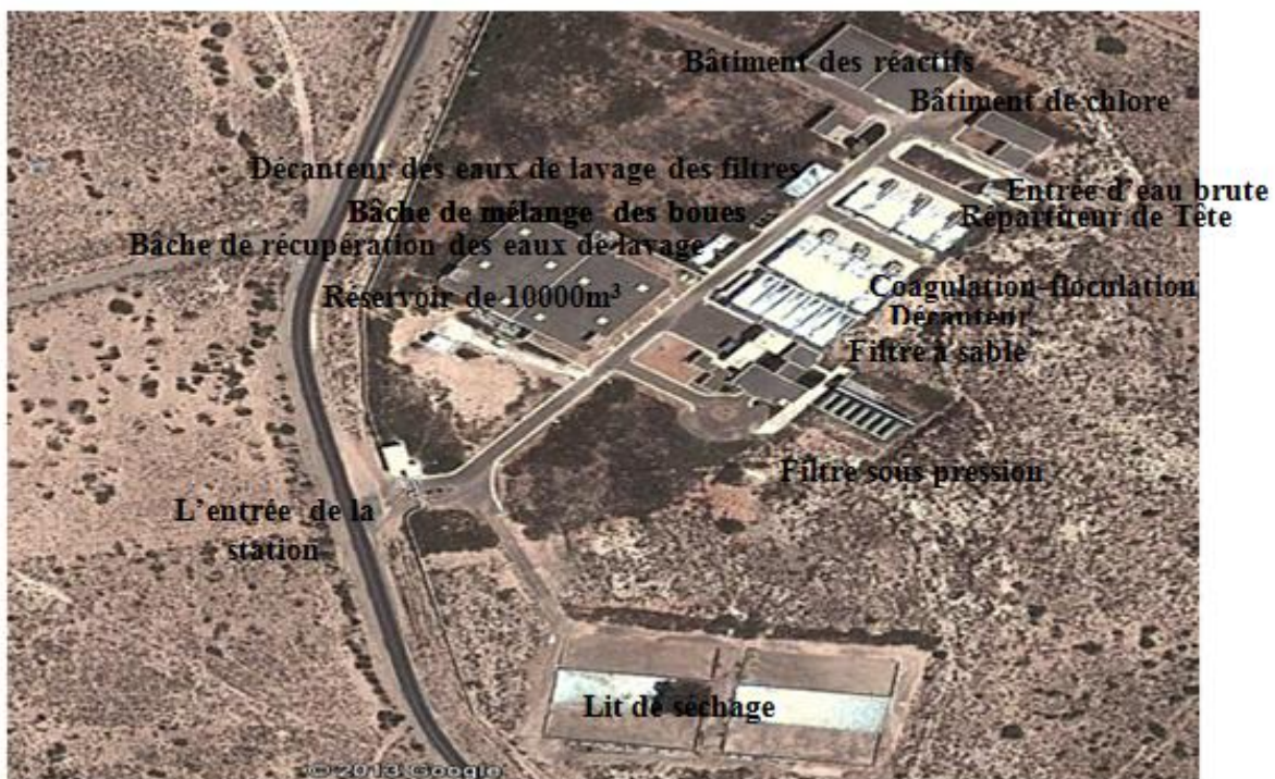
Figure 1 : Vue aérienne de la station de Tamri
