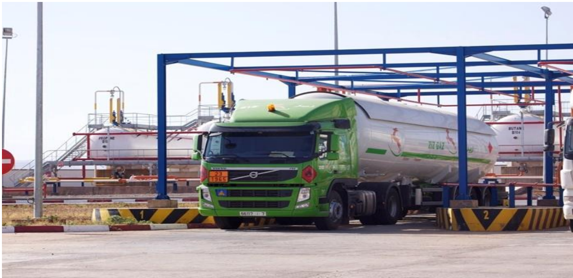
Figure 6 :Poste de déchargement de GPL
