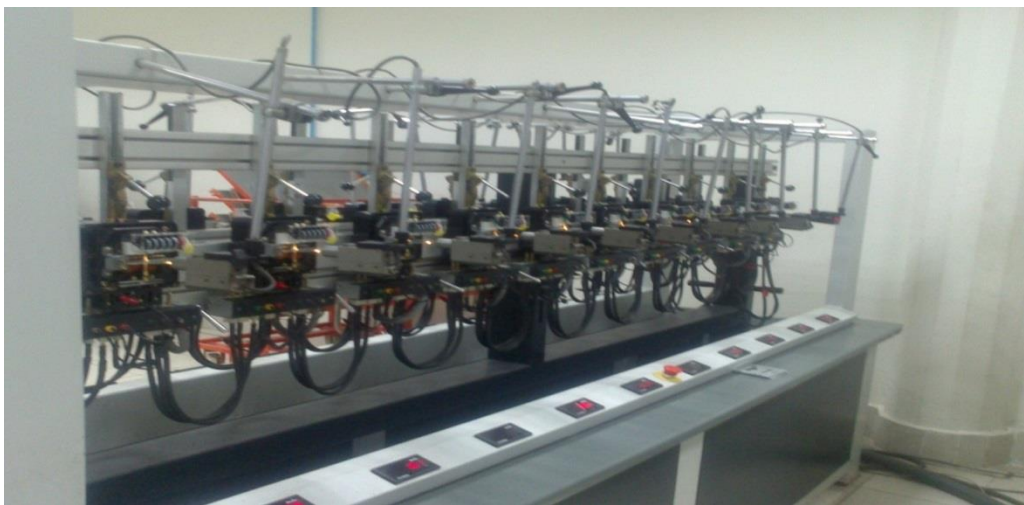
Figure 12 : contrôle la qualité des compteurs.
