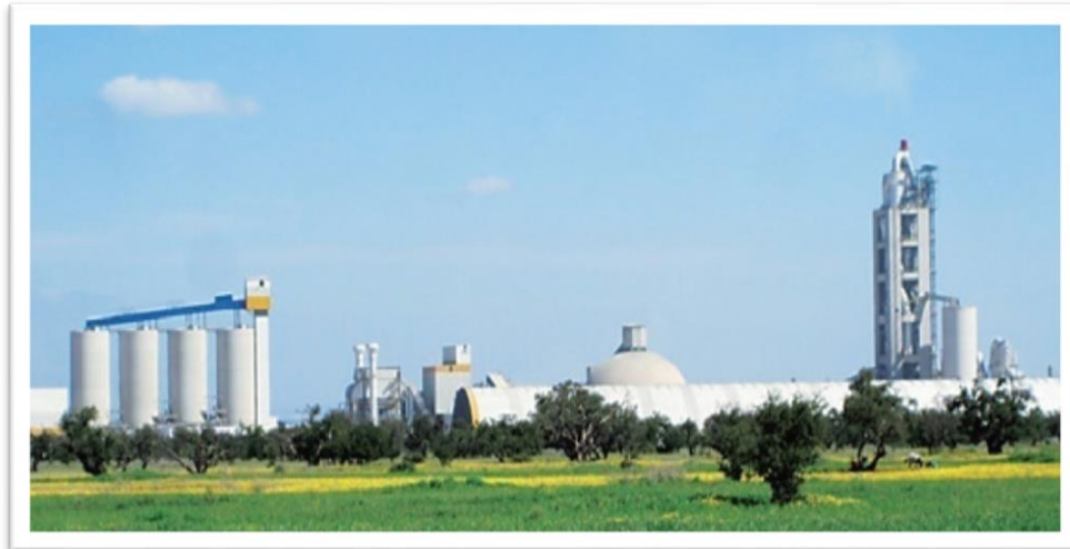
Figure 2 : Ciments du Maroc (Site Imi Mqorn-Aït Baha)
