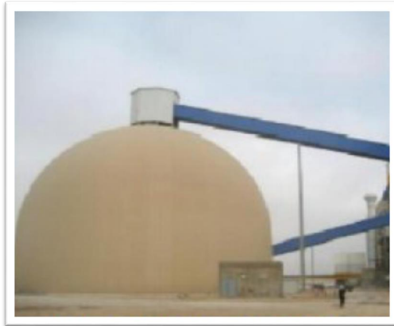
Figure 9: Dôme de stockage du clinker
