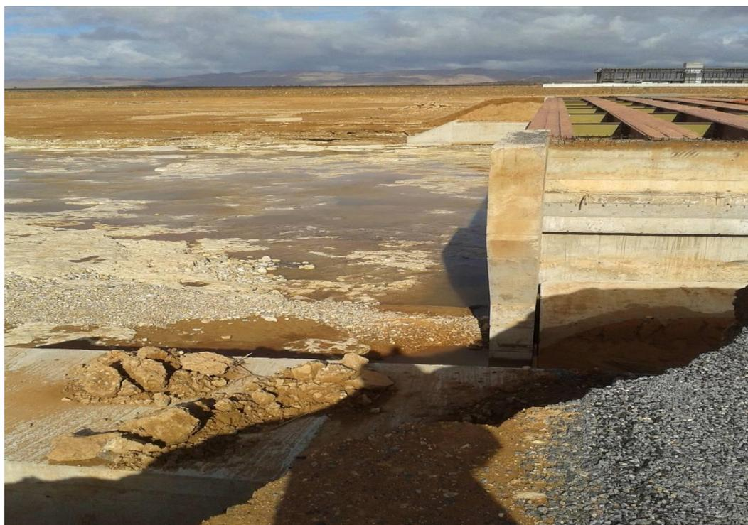
*Photo 1: Remblai d'accès du pont en cours de construction par l'ONDA emporté par la crue*
