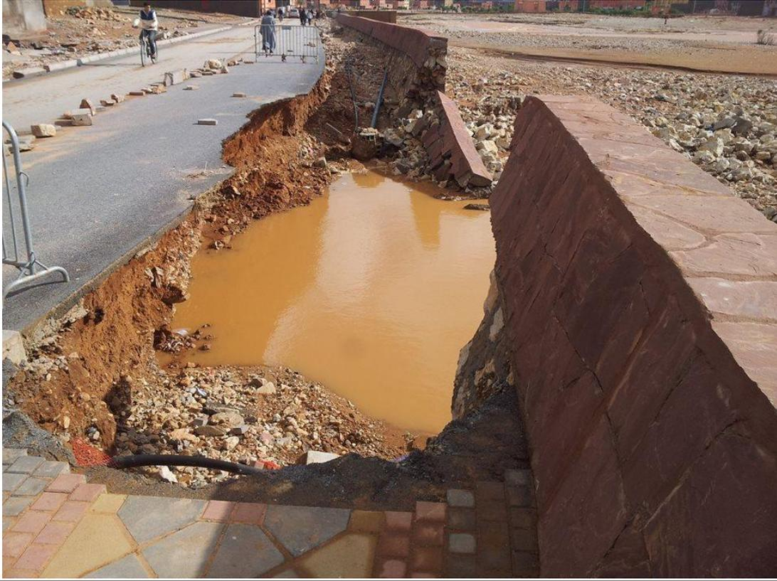
*photo 8 : Destruction d'un tronçon du mur de soutènement sur la rive gauche*
