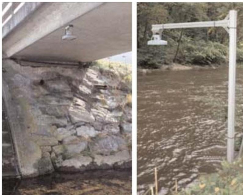
Fig VI.4: Montage d'OTT RLS sur une construction auxiliaire et sur un pont
